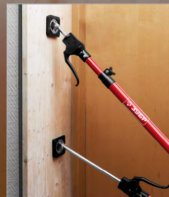
Фиксация стеновых панелей и конструкций при сборке
